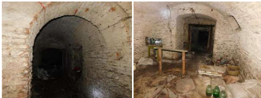
Foto nr.21, 22 Bolți de cărămidă, bine conservate
