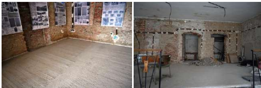
Foto nr.31, 32 Incintă parter-vedere generală
