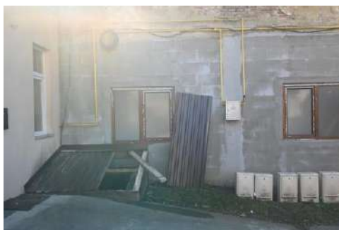
Foto nr.2,3, 4 Ziduri de cărămidă tencuite
