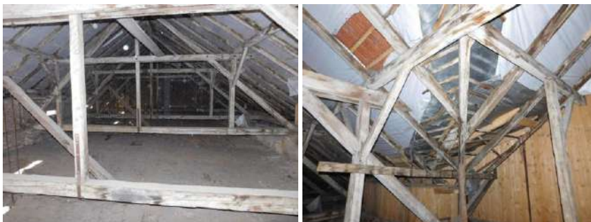
Foto nr.46, 47 Șarpantă-vedere generală
