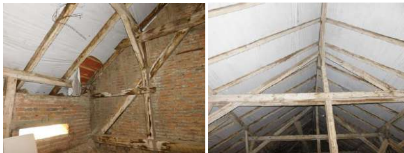
Foto nr. 9, 70 Căpriori cu halouri uscate de umiditate
