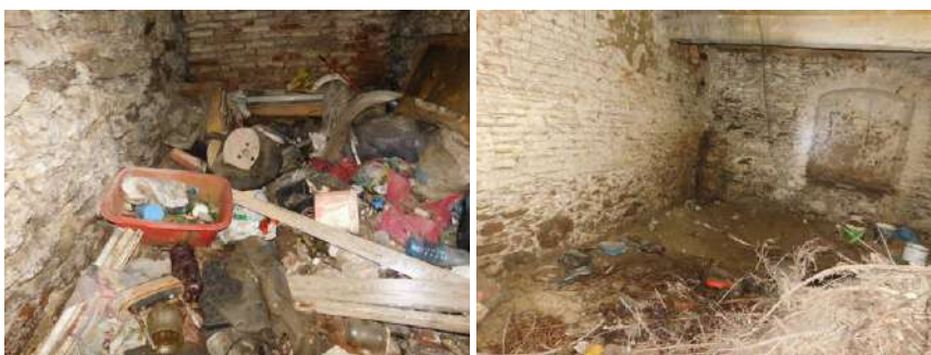
Foto nr.29, Deseuri Foto nr.30 Grinzi planșeu-bine conservate
