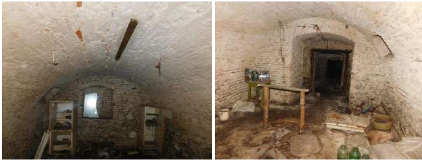
Foto nr.17, 18 Incinte subsol
