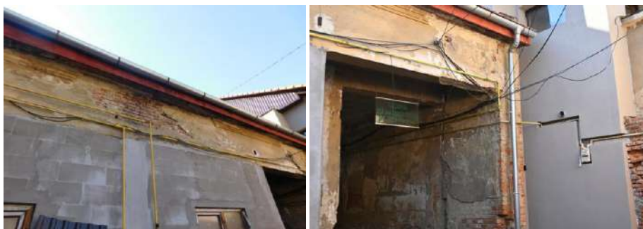
Foto nr.11, 12 Burlane și jgheaburi noi
