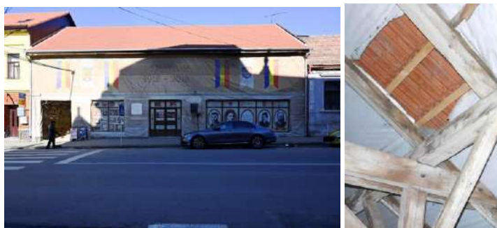
Foto nr.5, 6 Învelitoare confecționată din țiglă montată pe astereală de răsinoase
