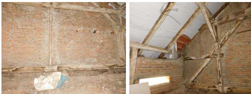
Foto nr.75, 76 Cosoroabă cu atac de insecte xilofage și putregai brun prismatic
