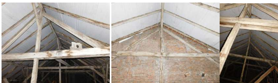
Foto nr.60, 61, 62 Coame-vedere generală
