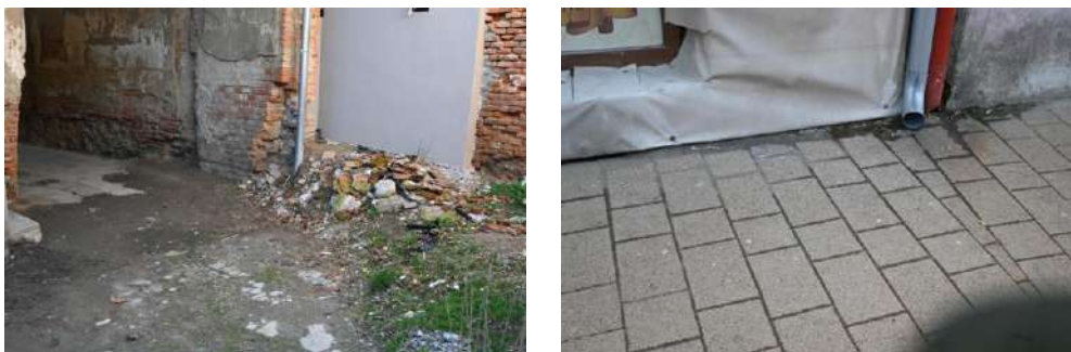
Foto nr.13, 14 Jgheaburi și burlane noi
