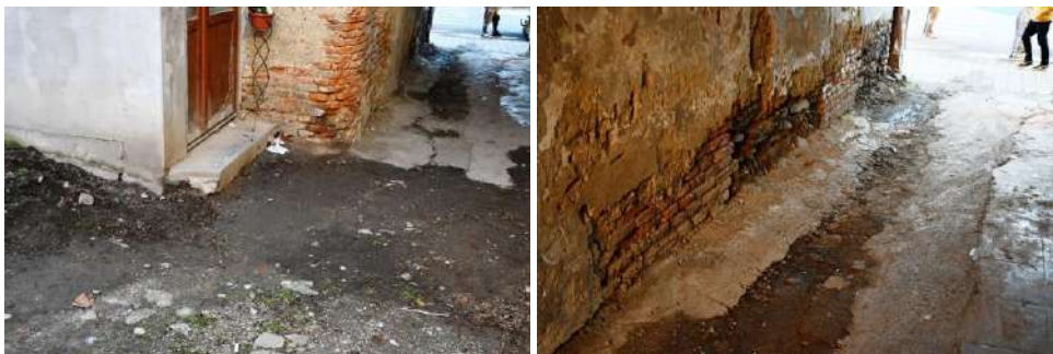
Foto nr.9, 10 Umiditate ascensională, pe exterior
