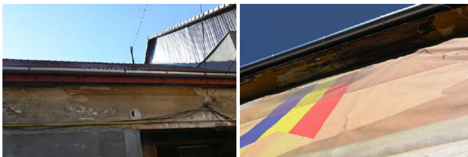
Foto nr.15, 16 Streașină, ușor degradată
