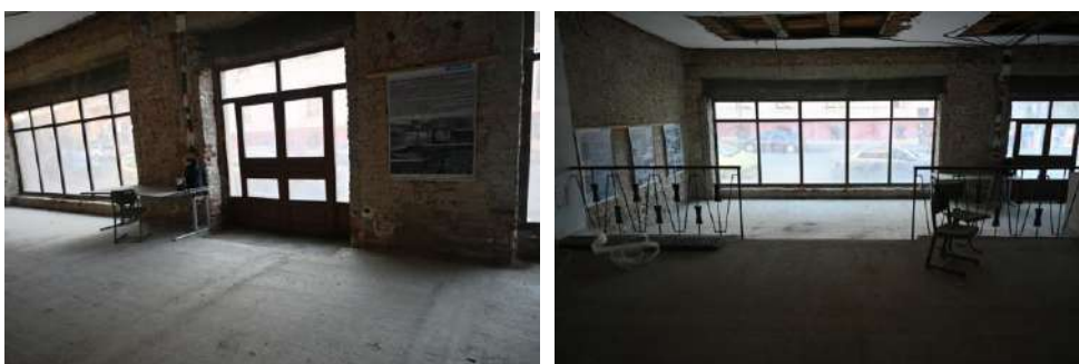
Foto nr.44, 45 Rame termopane
